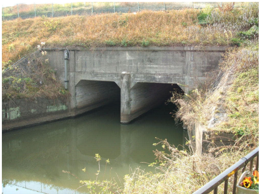
禹閘門樋（現在）
